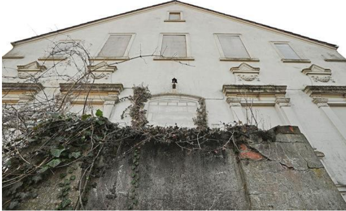
Die nördliche Giebelwand der Villa Heimann soll für das geplante Mahnmal erhalten bleiben. Zur Abstützung müssen Teile der Längsseiten vom Abbruch verschont werden. Foto: Axel Roll
