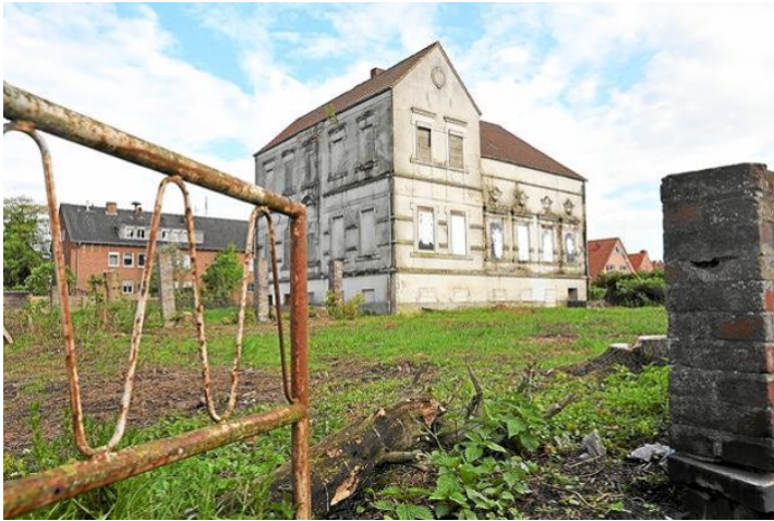
Das Schicksal der Villa Heimann ist seit gestern Abend besiegelt. Nur eine Fassadenecke soll erhalten bleiben. Damit folgte die Mehrheit des Bauausschusses dem Vorschlag der GAL. Foto: Axel Roll
