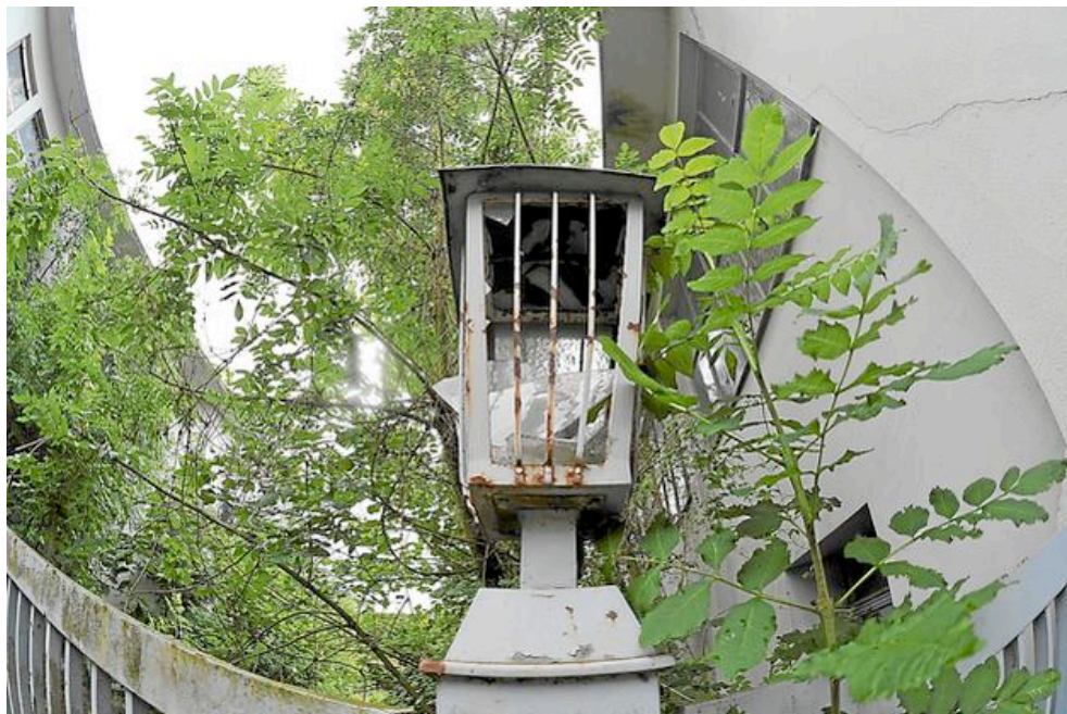
Wenn alles weiter wie geplant läuft, könnte auf dem ehemaligen Fabrikgelände von Wattendorff im nächsten Jahr gebaut werden. Für die alten Betriebsgebäude gibt es bereits eine Abrissgenehmigung. Foto: Axel Roll
