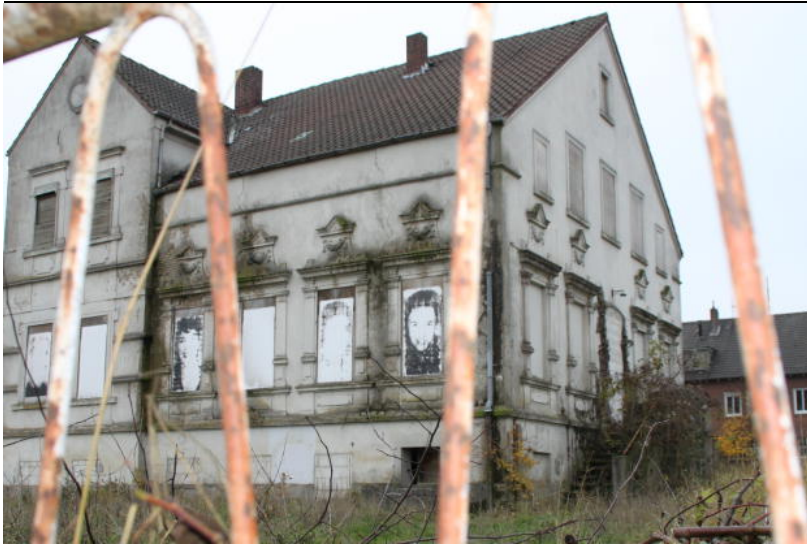
Wieviel »Villa Heimann« stehen bleiben soll, ist noch unklar. Der Technische Beigeordnete Reinhard Niewerth wartet auf politische Entscheidungen. Bis dahin wird nur das abgerissen, was den Neubau der Feuerwache nicht behindert Detlef Held
